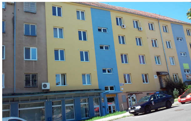
Vchod administratívnej budovy HNK pred zateplením a po zateplení, úpravy fasády, výmeny okien schodiska a vstupných dverí.
