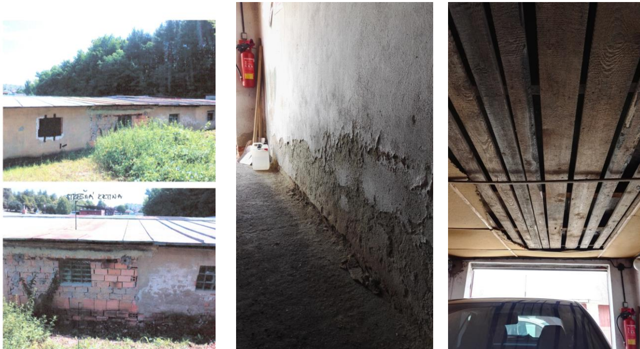
Garáž pred rekonštrukciou
