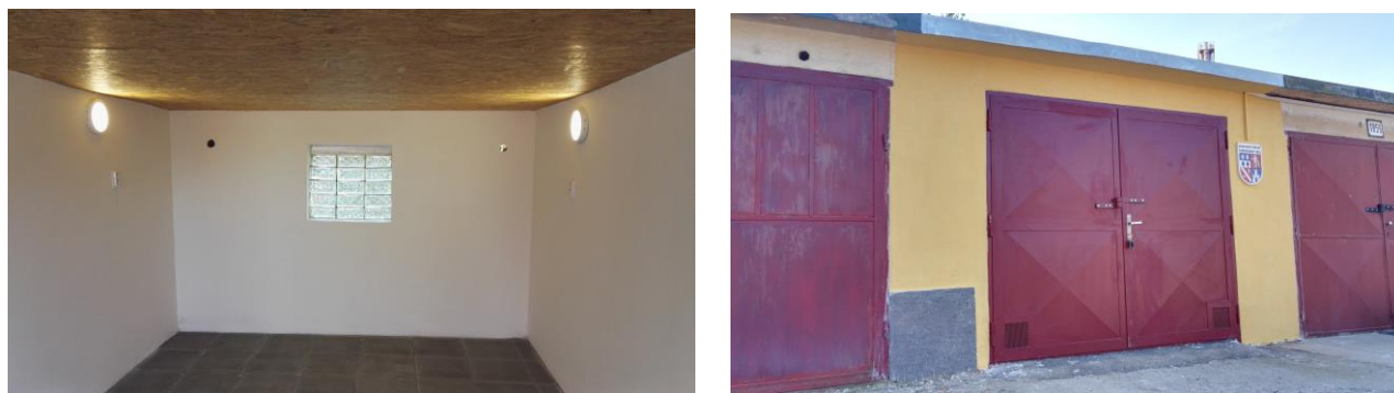
Garáž v radovej výstavbe po rekonštrukcii
