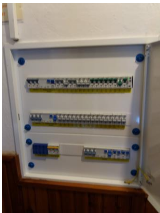
Rozvodnice po výmene
